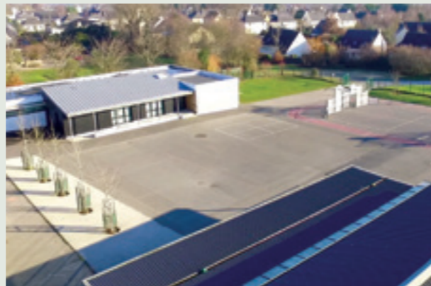
Extension du groupe scolaire Le Petit Prince.
